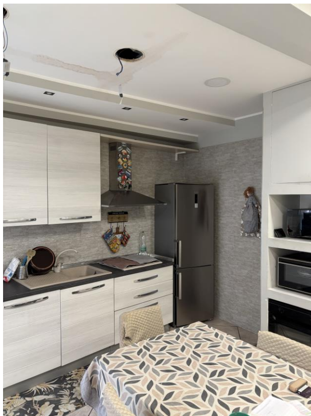
Foto 12: particolare infiltrazioni cucina
